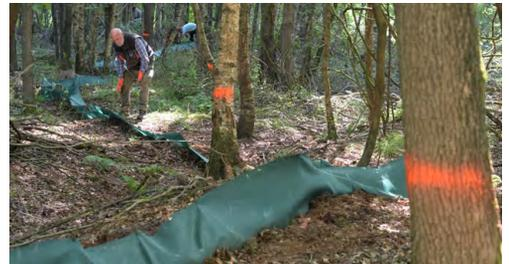
Der rund 1.800 Meter lange Amphibienschutzzaun wurde zur temporären Lenkung der Amphibien-Wanderungen im 45-Grad-Winkel errichtet.
