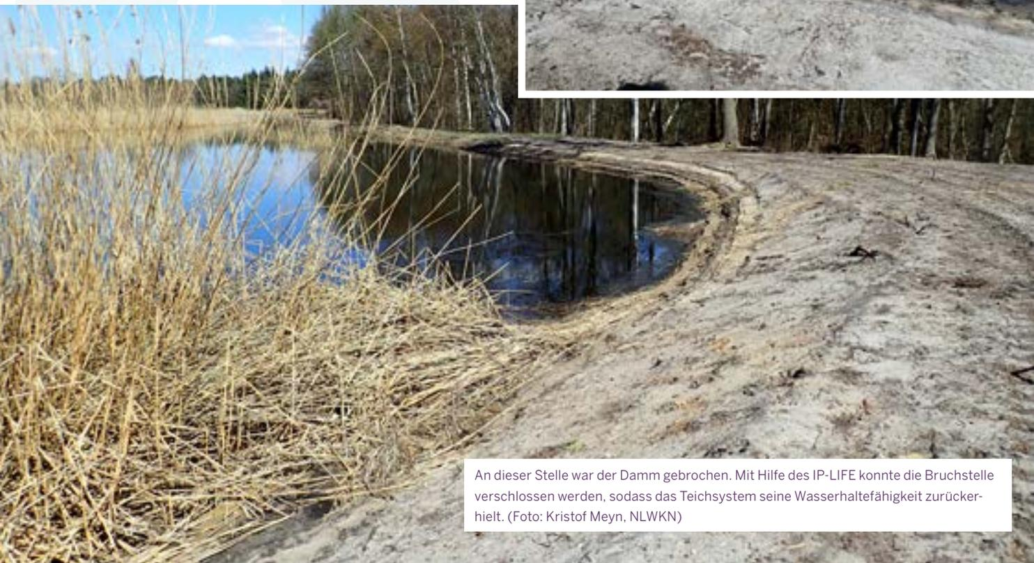
An dieser Stelle war der Damm gebrochen. Mit Hilfe des IP-LIFE konnte die Bruchstelle verschlossen werden, sodass das Teichsystem seine Wasserhaltefähigkeit zurückerhielt. (Foto: Kristof Meyn, NLWKN)
