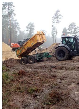
Die Ausschachtung wird mit dem von den Dünen entfernten Oberboden verfüllt und anschließend mit dem zwischengelagerten Sand überdeckt (Foto: Thomas Kutter, NLWKN)
