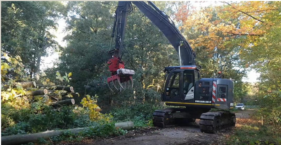
Die Gehölze wurden mit Hilfe eines Baggers mit weitem Ausleger gerodet (Foto: RVR)
