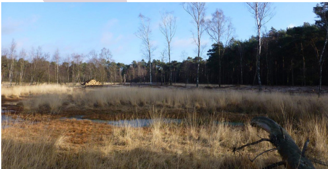
Nach Abschieben des Oberbodens ist der Sand freigelegt. (Foto: Norbert Neikes, Biologische Station Krickenbecker Seen)
