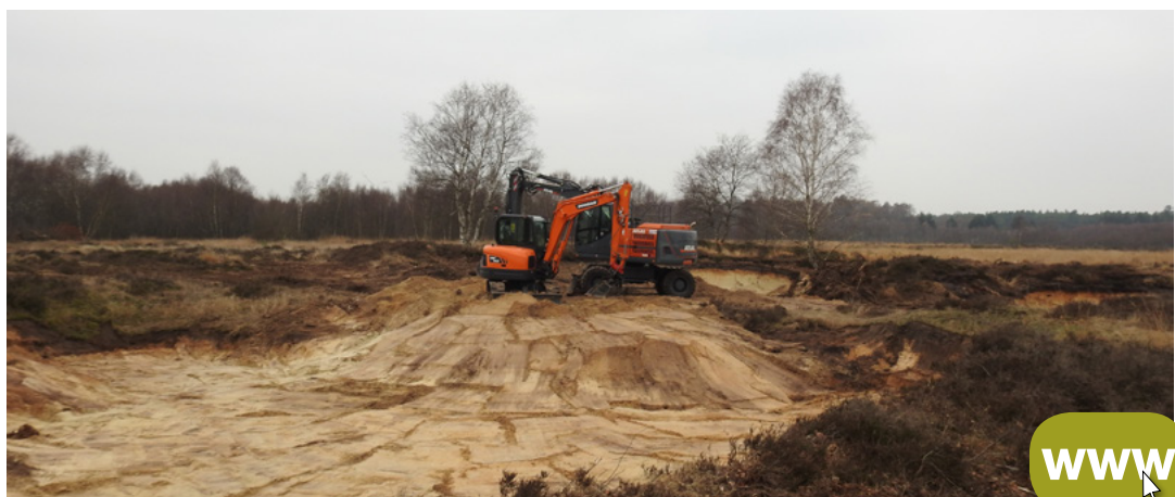
Instandsetzung von Heiden, Binnendünen und Kleingewässern an sechs Standorten in der Diepholzer Moorniederung (C38, C44, C45, C46, C47, C49)
