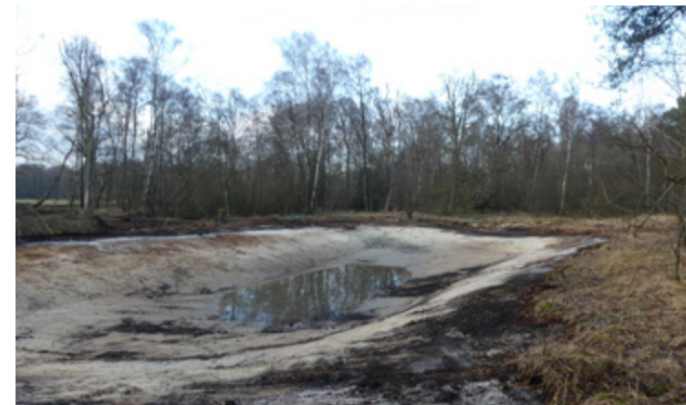
Nach den Gehölzarbeiten wurden die drei Kleingewässer vertieft; aus dem abgeschobenen Bodenmaterial wurde ein Erdwall zur Besucherlenkung angelegt. (Foto: Sebastian Schmidt, Bezirksregierung Münster)
