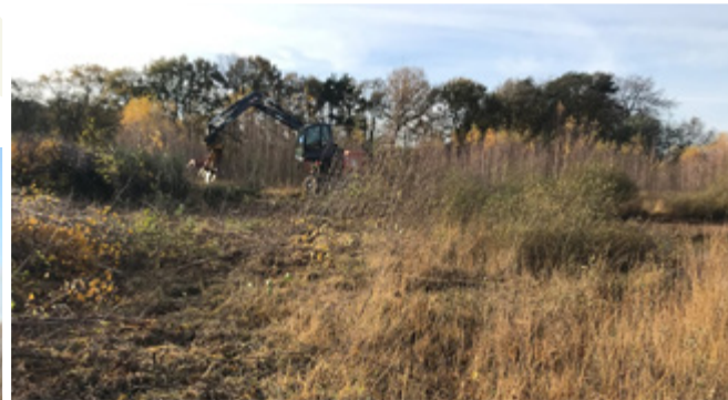
Beginn der Arbeiten im November 2020 (Foto: Hartmut Storch, Biologische Station Kreis Steinfurt)
